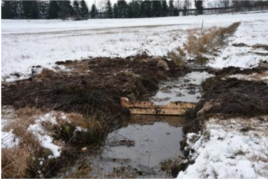
Frisch eingeschlagene Spundwand in Entwässerungsgraben im Üsser Sack. Bild Stiftung Frauenwinkel
